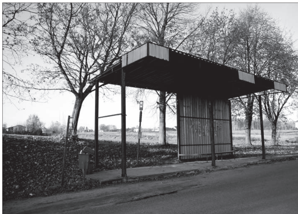
Przystanek autobusowy. Na jego remont i pieniędzy i dobrej woli zabrakło
