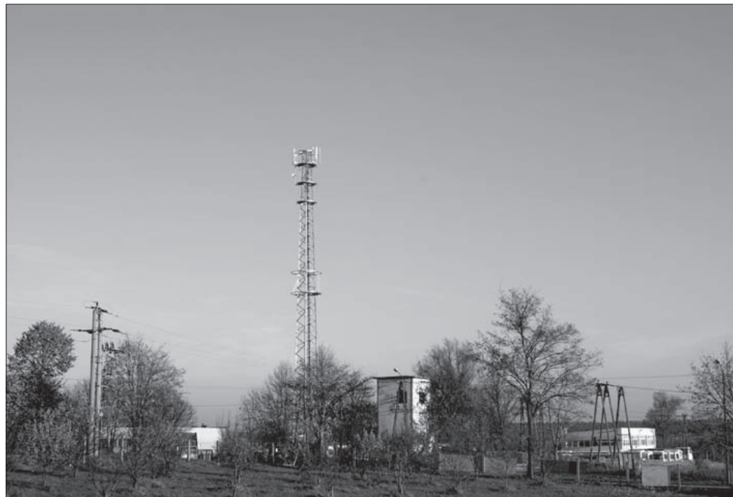
Stacja bazowa telefonii komórkowej Orange
